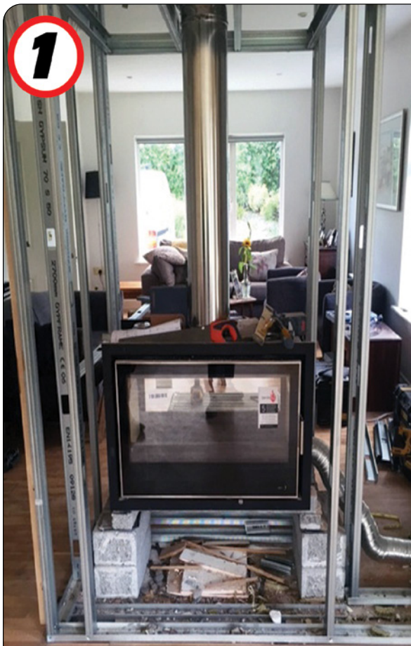
1 - INSTALLING INSERT STOVE USING METAL STUD FRAME
