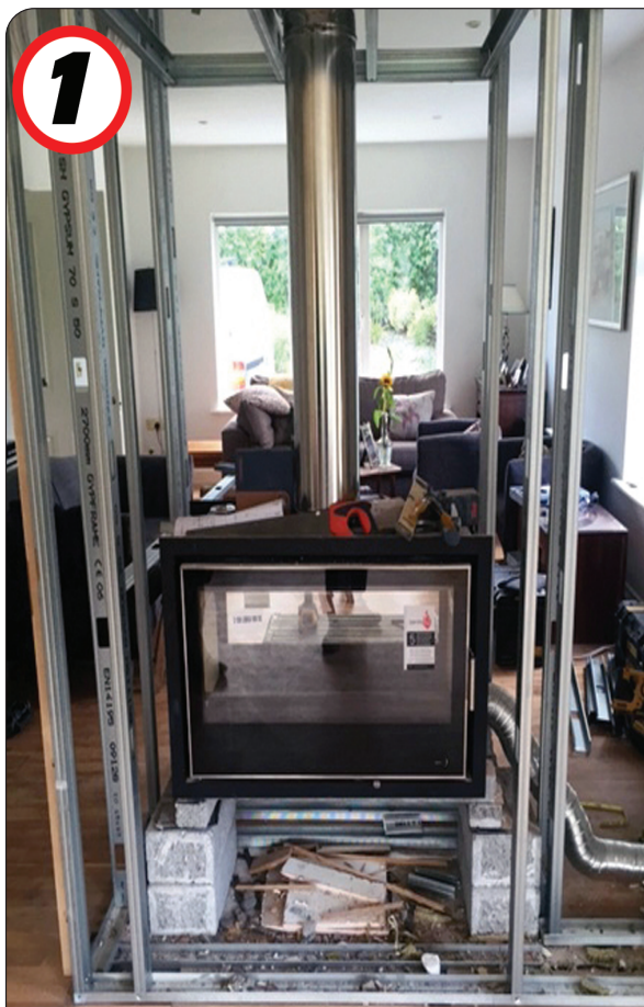
1 - INSTALLING INSERT STOVE USING METAL STUD FRAME
